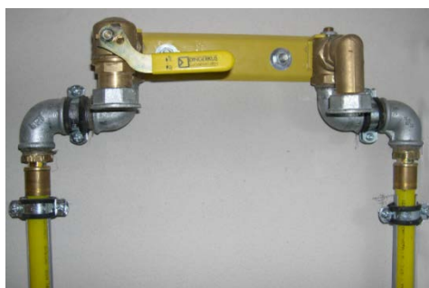
Abbildung 7.3: Gas-Zähleranschlussplatte – Anschluss mit nicht metallenen Leitungen
