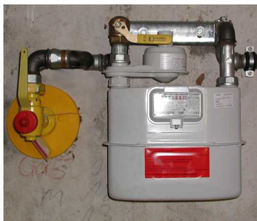
Abbildung 4.5: Einzelspartenanschluss mit Gaszähler und Zählerregler
