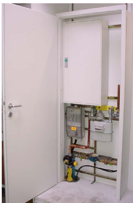
Abbildung 6.2: Beispiel einer Hausanschlussnische
