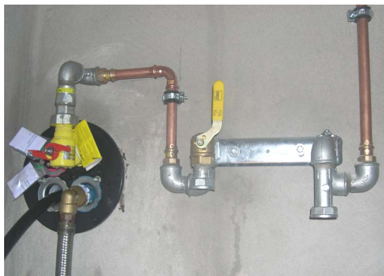
Abbildung 7.2: Gaszähler-Anschlussplatte bei Kunststoffleitungen in der Gas-Hausinstallation
