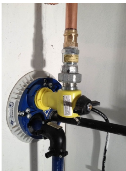
Abbildung 4.3: Beispiel einer Mehrsparten Hauseinführung
